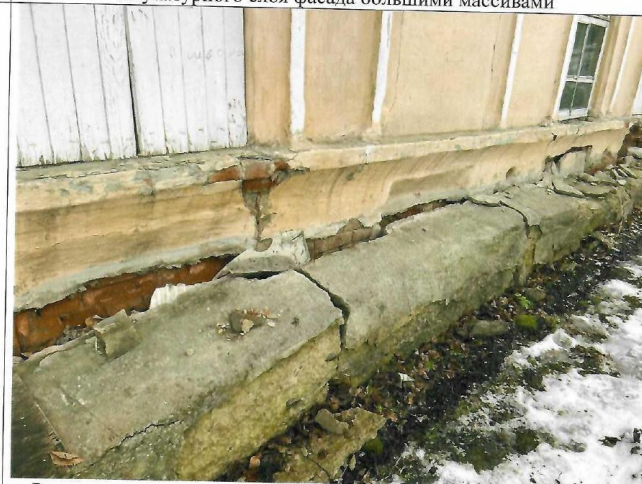
Разрушение цокольного пояса, отхождение от фасада. Намокание стен цокольной части в результате утраты штукатурного слоя.
