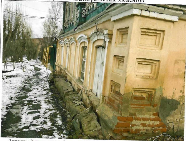
Западный угол дома (уровень 1-го этажа). Трещины. Отслоение штукатурного слоя, поверхностное разрушение кирпича на пилястре.
