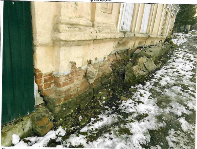
Разрушение цокольного пояса с частичной утратой фрагментов пояса.
