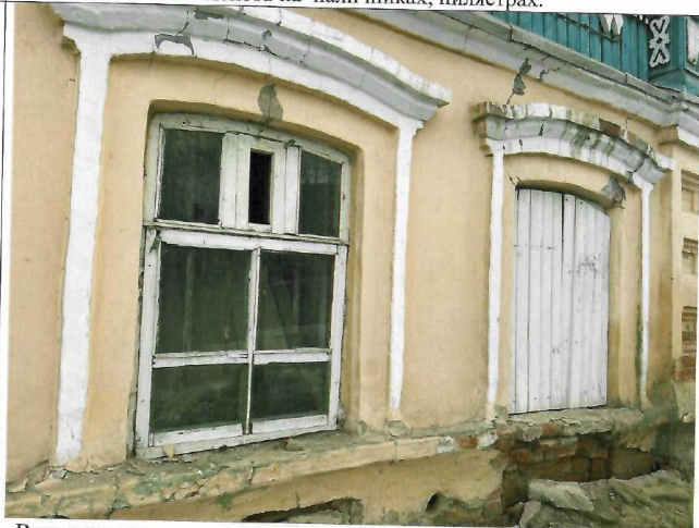
Вертикальные трещины над проемами, деформации междуэтажного пояса, осыпание штукатурного слоя в цокольной части.
