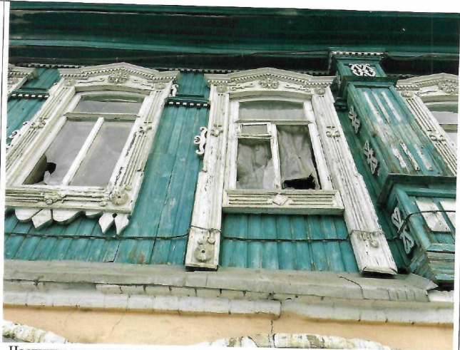
Частичное отсутствие остекления, утрата деревянных декоративных элементов на наличниках, пилястрах.
