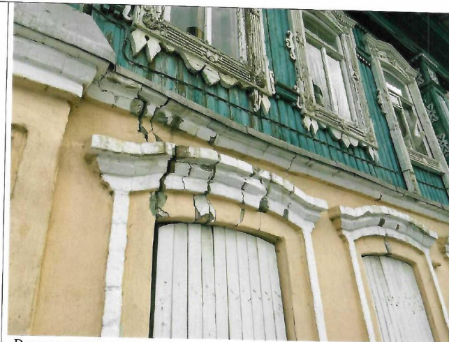
Вертикальные трещины над проемами, деформации междуэтажного пояса, коробление и утрата окрасочного слоя.
