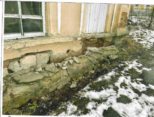
Разрушение цокольного пояса, отхождение от фасада, отпадение штукатурного слоя фасада большими массивами
