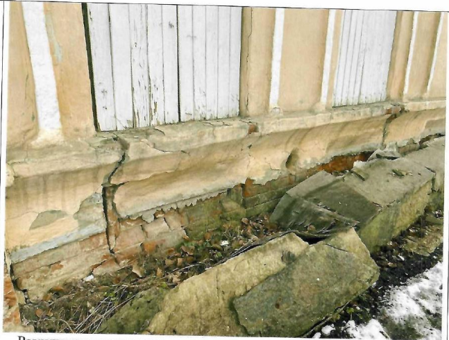
Разрушение цокольного пояса, отхождение от фасада. Намокание стен цокольной части в результате утраты штукатурного слоя. Трещина в стене в углу проема.
