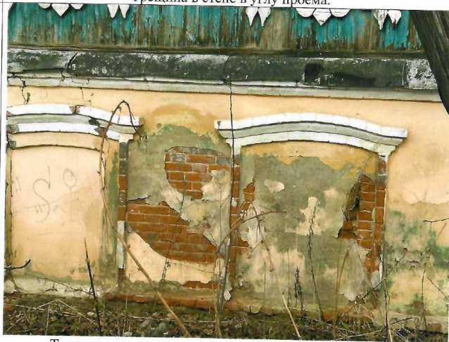
Трещины над проемами, отслоение штукатурного слоя, выкрашивание кирпича.
